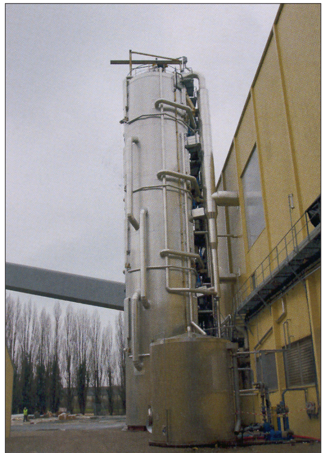
شکل ۲: آپارات پخت ۲ عمودی و مداوم در کارخانه قند (Roye)
