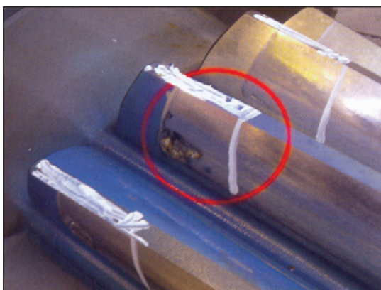
شکل ۱۴: ایجاد سوراخ در قسمت انتقال نیروی دنده
